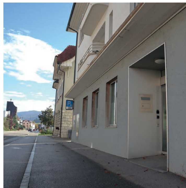
Le bâtiment de l'ancienne BCBE, à Malleray, a été choisi pour sa situation centrale dans la commune. Dan Steiner
